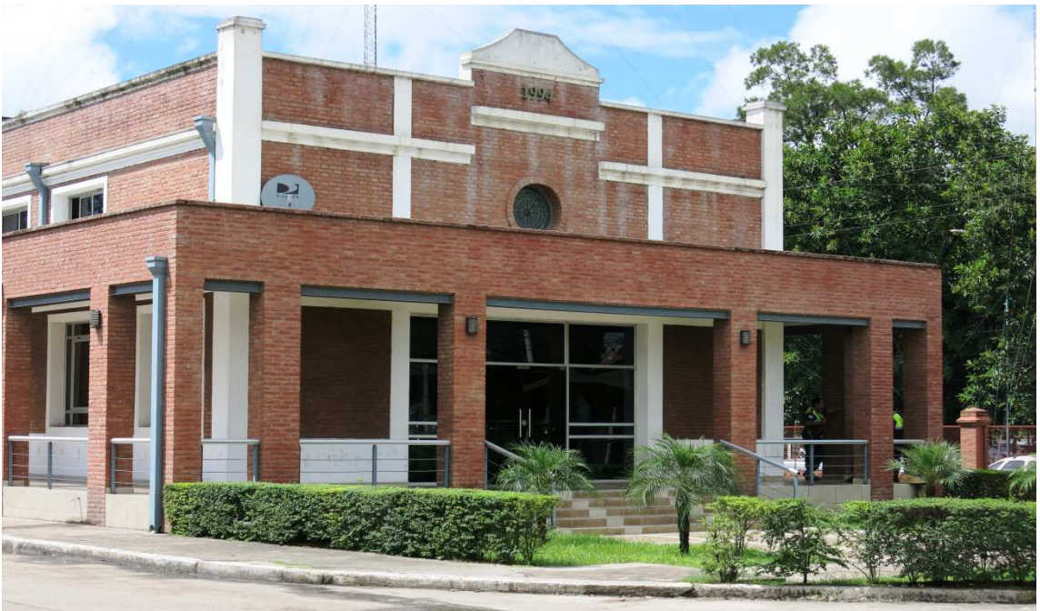
Edificio de Administración del Ingenio La Florida. [Fotografía de Patricia Gutti]. (Tucumán, 6/03/2015).
