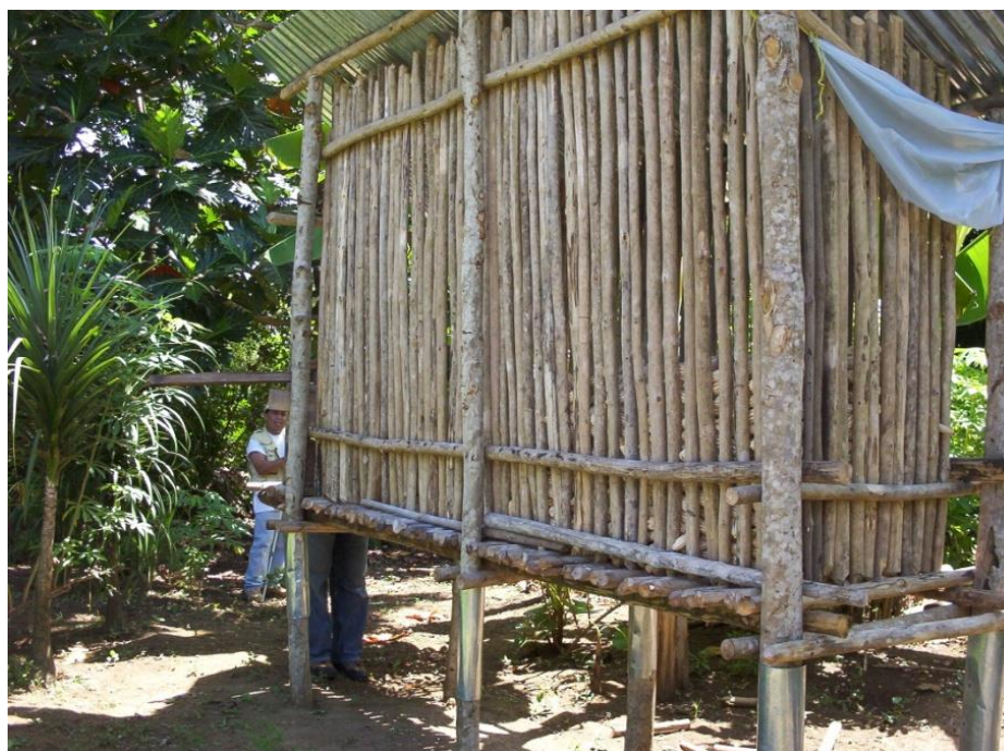
El tejado metálico y los pilares forrados de hojalata que hace resbalar a los roedores, impidiendo su entrada
