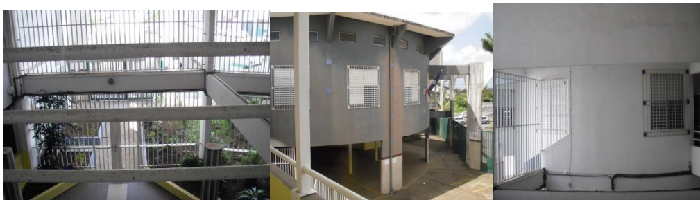
Fotografías 98 y 99. Tomadas el 30 de Mayo de 2015. A la izquierda y en el centro, vista del primer patio interior del edificio del colegio Cassien Saint Claire. A la derecha imagen de los muros de la biblioteca tomada desde el pasillo de la sala de profesores.
