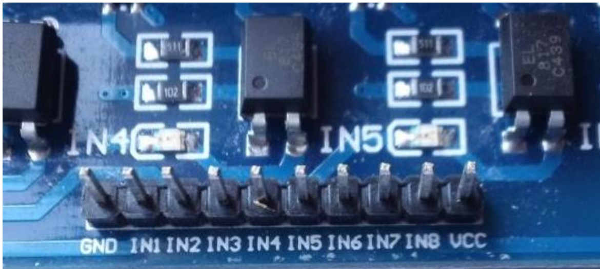
13. Imagen conexiones módulo relés
