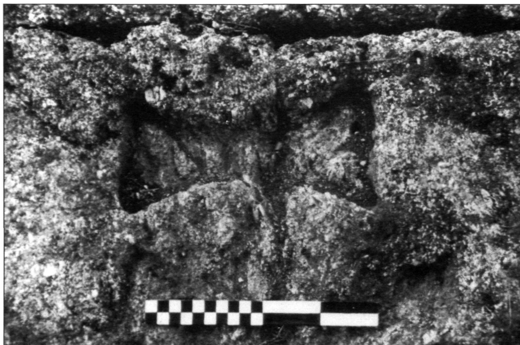
Lám. IV) Detalle de una de las grapas del punto 33. Nótese cómo la zona media aparece con una muesca realizada, con toda probabilidad, en el momento de su robo.
