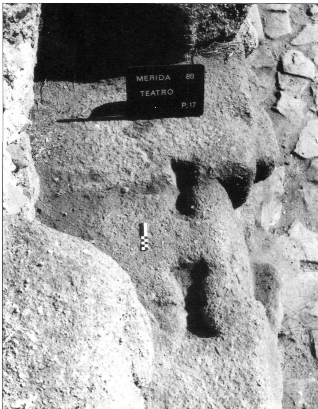
Lám. II) Particular de dos grapas en sucesión. Obsérvese su buen estado a pesar de lo erosionado de la piedra, así como su gran profundidad.
