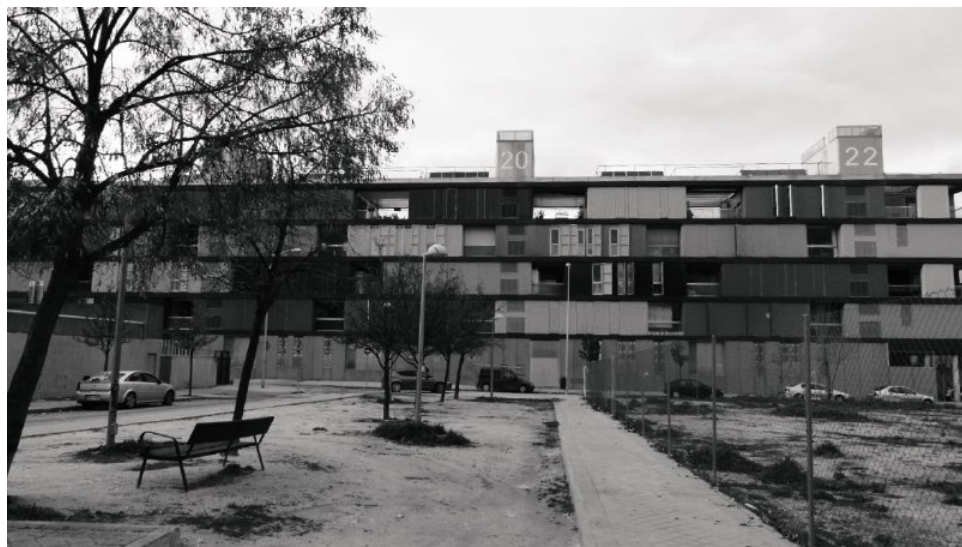
Fotos 13. Viviendas públicas (2019, 2015, 2019)
