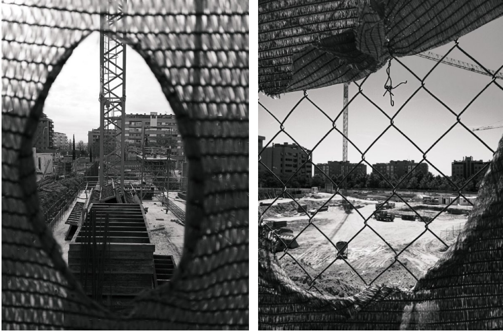
Fotos 3. Obras en dos solares del PAU de Carabanchel (Verano de 2019)
