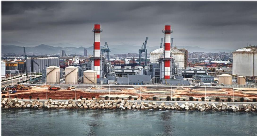
Foto 4. Central Térmica de Ciclo Combinado del Puerto de Barcelona
