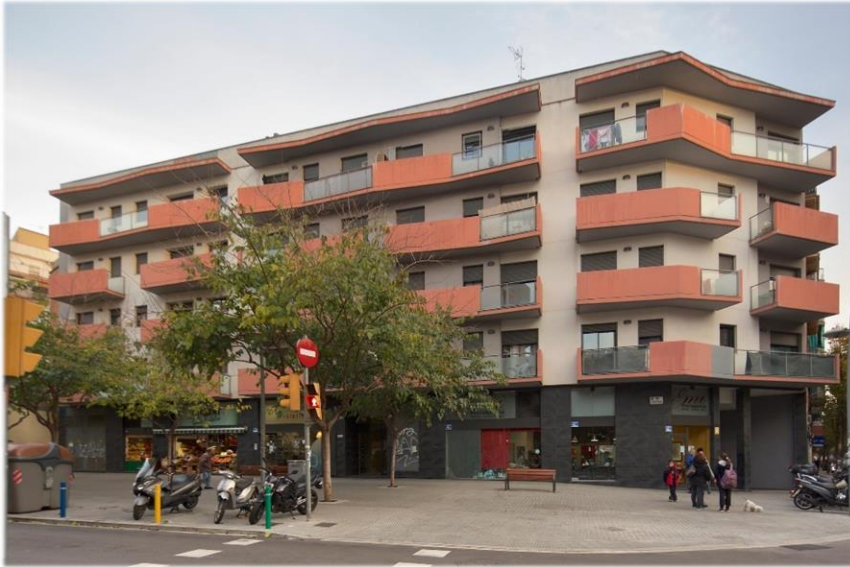
Foto 8. Edificio carrer Aprestadora 61-65 de l'Hospitalet de Llobregat
