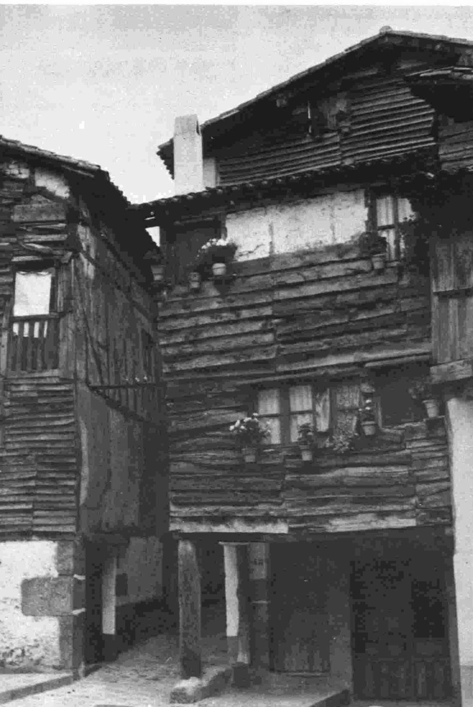
Casa con soportal y fachada de tablazón de madera. Valverde de La Vera
