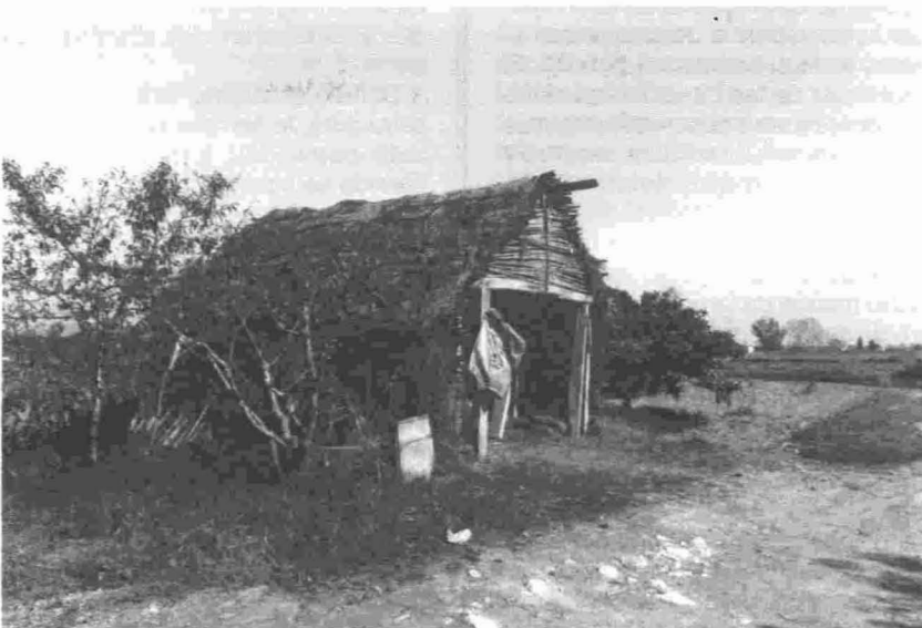
Barraca almacén con paredes de brossa y una gran puerta para guardar el carro. Foto de M. Mar Villalalbí.
