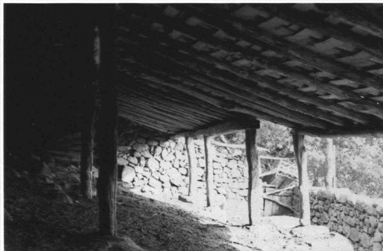
Detalle del entramado de madera en una majada.
