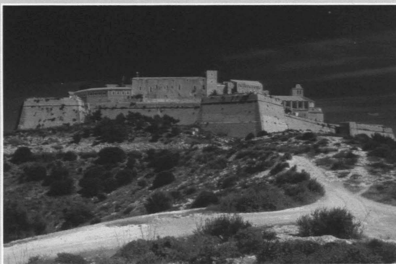
Foto Raymar. Vista de las murallas desde el sur.
