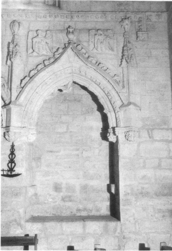
Fig. 5. Arcosolio del costado meridional.
