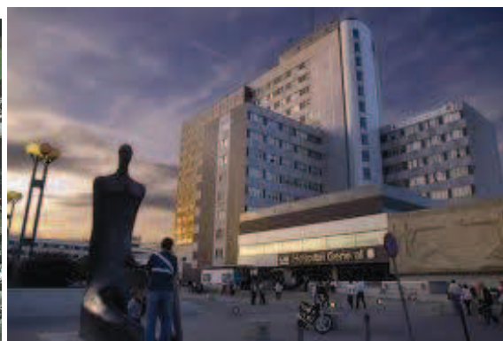
Hospital "La Paz". Fachada e ingreso
