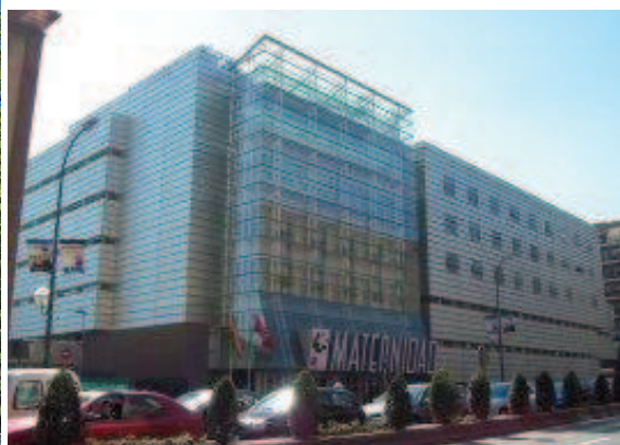
Hospital "Gregorio Marañón". Edificio Maternidad
