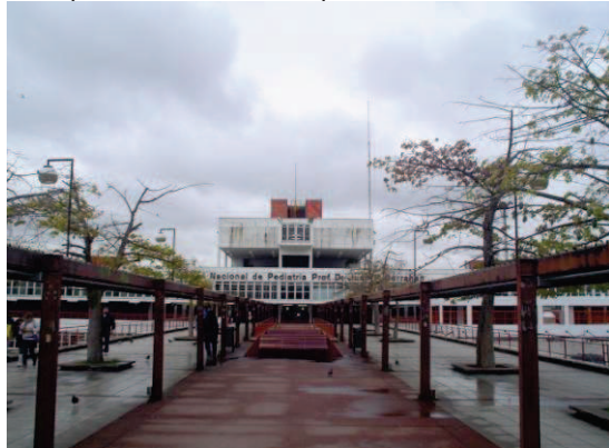
Hospital Garrahan. Ingreso Pichincha
