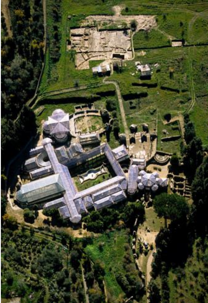
La Villa del Casale con la cubierta de vidrio y metal que reproduce los volúmenes antiguos
